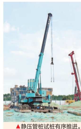
▲静压管桩试桩有序推进。 本报讯(文/图 记者 蔡锦绵 通讯员 郑涛 裴宗文)近日,苏颂天文馆项目静压管桩试桩
