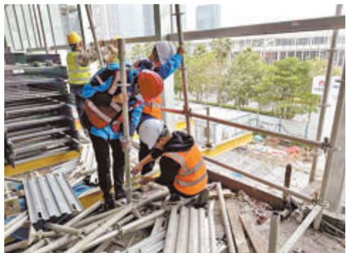
在会展五期项目施工现场,青年突击队正加紧施工。(两岸区域性金融中心片区指挥部 供图)
