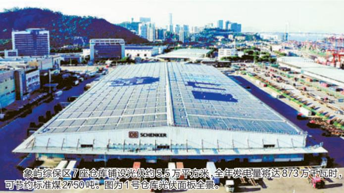
象屿综保区7座仓库铺设光伏约5.5万平方米,全年发电量将达873万千瓦时,可节约标准煤2750吨。图为1号仓库光伏面板全景。
