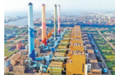
台湾电力公司亏损严重。图为该公司的台中火力发电厂。
