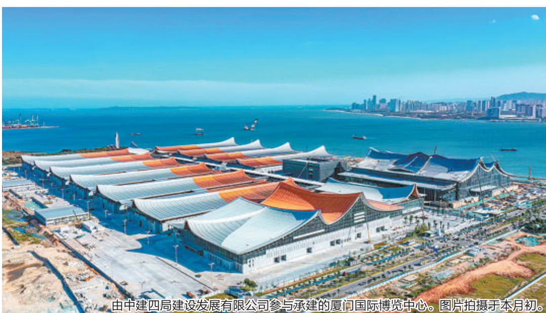
由中建四局建设发展有限公司参与承建的厦门国际博览中心。图片拍摄于本月初。
