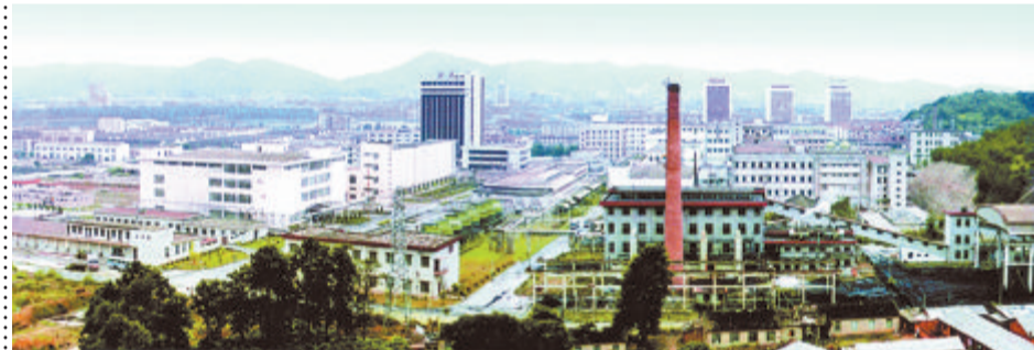
1989年,由中建四局建设发展有限公司承建的厦门柯达感光厂荣获鲁班奖,这是中建四局获得的首个鲁班奖,也是福建省获得的第一个鲁班奖。
