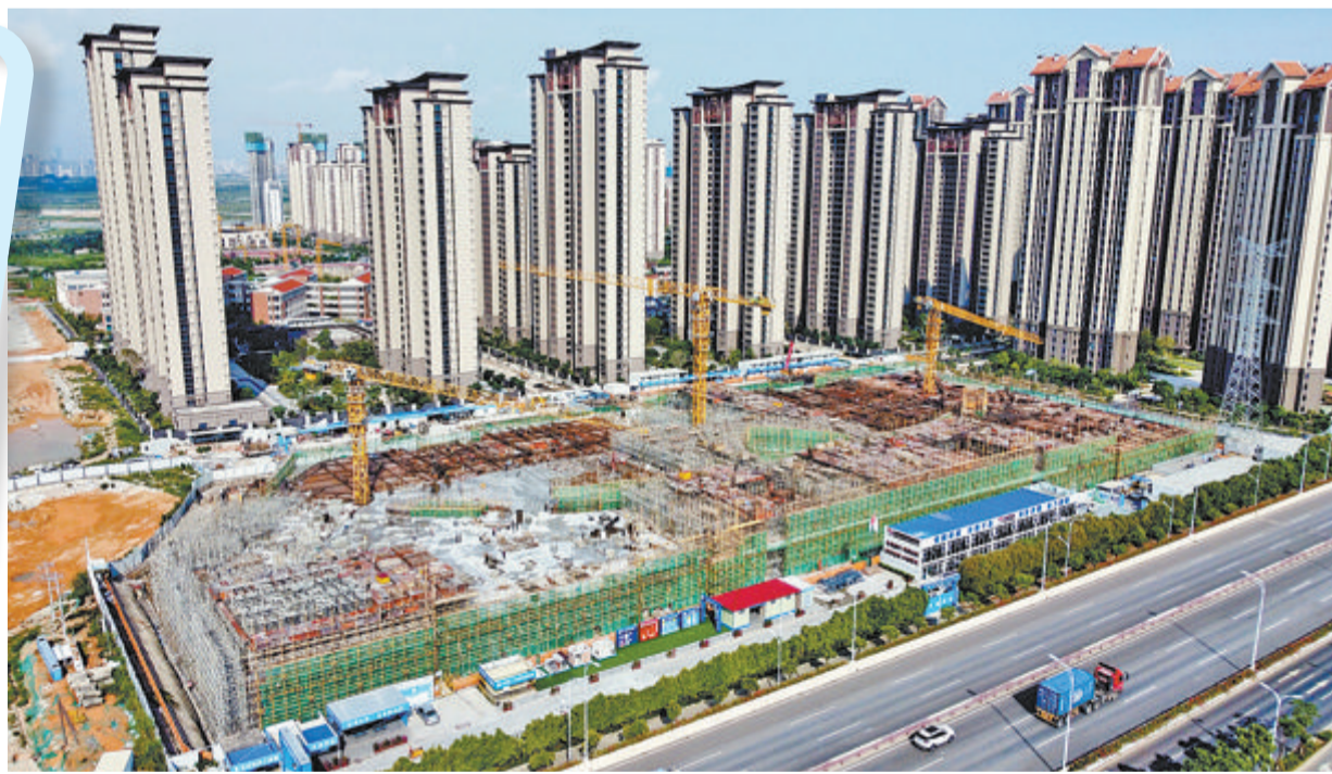
▲厦门SM马銮湾项目全面进行上部主体结构施工。
