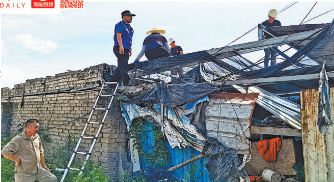
滨海中队对黄厝社区城中村内的违建铁皮棚进行拆除。
