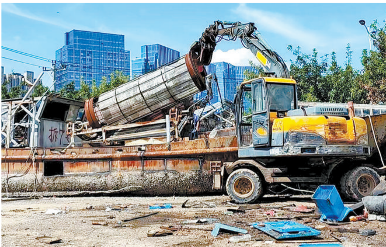
▲工作人员操作挖掘机拆解“三无”船舶。(本组图/本报记者 杨进福 摄)
