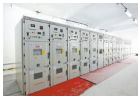
▲厦门时代新能源电池产业基地项目(一期)10千伏过渡保障供电项目昨日成功送电。图为高压中置柜等设备。
