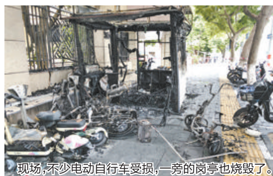
现场,不少电动自行车受损,一旁的岗亭也烧毁了。
