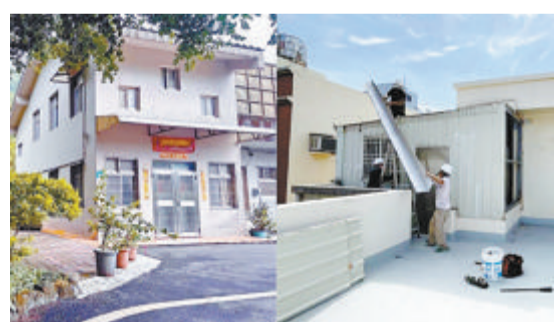
赖清德老家(左)被证实确实属于违建，但至今未拆。柯文哲老家违建(右)已拆。
