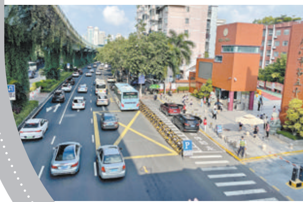
▲改造后的莲前西路(厦门五中段),新增了3个即停即走车位,方便学生上下车,减少拥堵风险。
