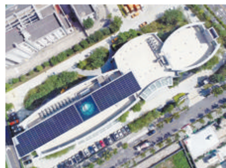
厦门供电公司观音山基地绿色微电网项目竣工并网发电。(厦门火炬新源电力科技有限公司 供图)
