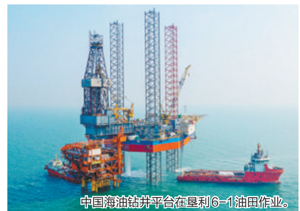
中国海油钻井平台在垦利6-1油田作业。
