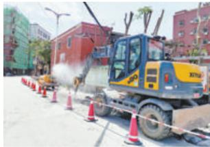
▲市政水务集团严格落实安全文明施工措施,图为在路面破除施工时,采用雾炮车降尘。(市政水务集团 供图)
