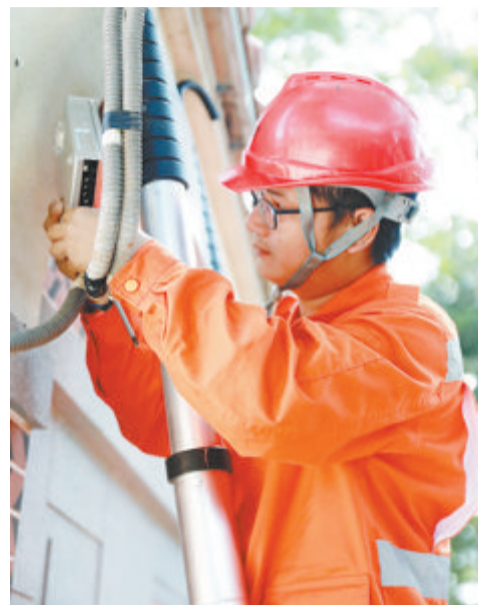
翔安市政集团环境公司路灯班站的工作人员陈奋斗正在更换夜景灯带的控制器。
