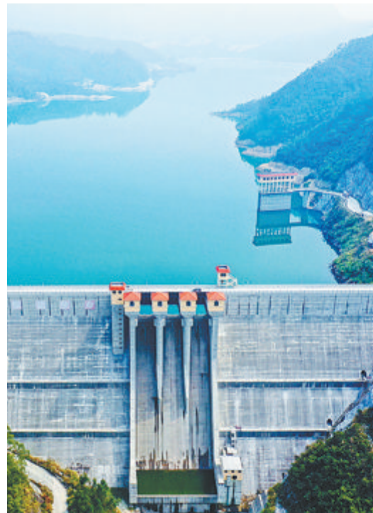
▲枋洋水利枢纽工程上存水库
