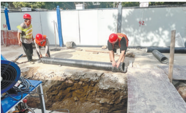
浦南新村小区供水管网改造过程中,市政水务建设者将原有的老旧水管换成崭新的球墨铸铁管。(市政水务 供图)
