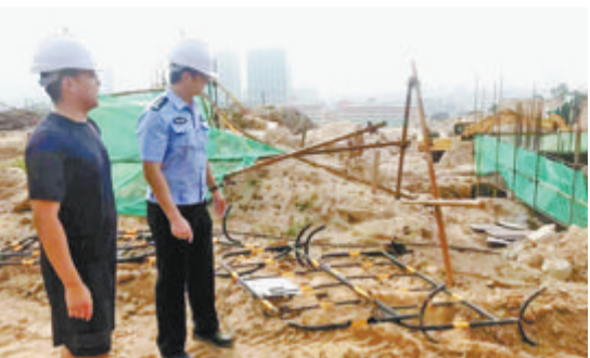
庄越宇(右)在检查施工现场。
