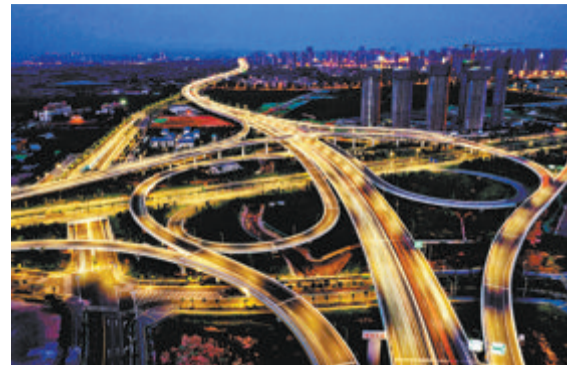
翔安立体化交通枢纽已具雏形。
