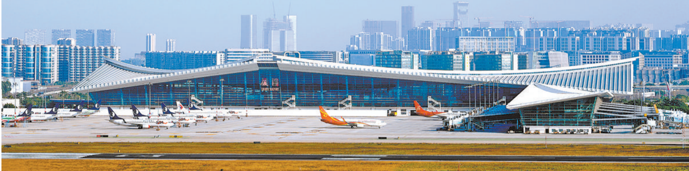
国际航班从厦门高崎国际机场T4航站楼前飞过。
