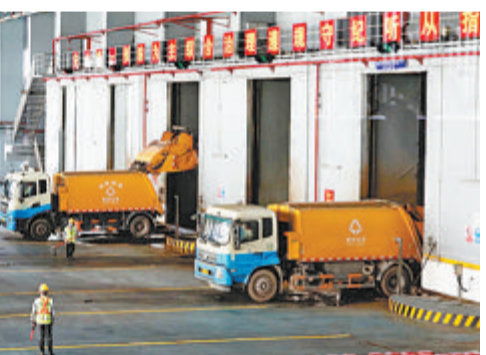
垃圾焚烧发电厂内，垃圾运输车正在作业。（本报记者 王协云 摄）
