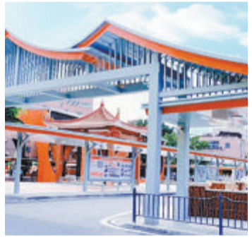
已完工的景观连廊工程。
