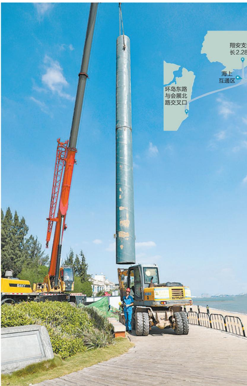
第三东通道A1标段开工仪式在观音山举行。图为工人进行施工栈桥钢管桩吊装作业。（本报记者 王协云 摄）
