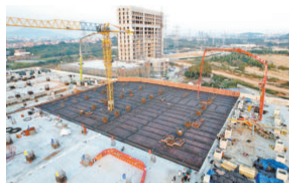
社头车辆基地最后一块盖板浇筑中。
