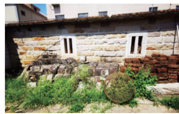
前格村一座房屋边瓦片、砖块随意堆放。
