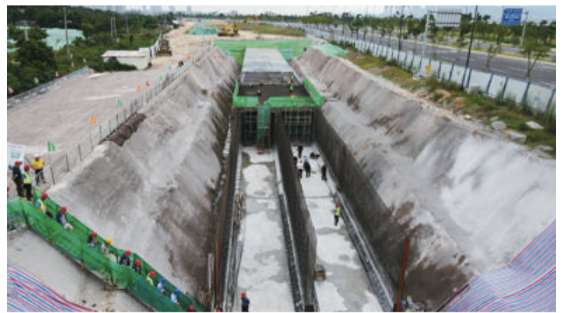
北溪引水左干渠道马銮湾新城段。
