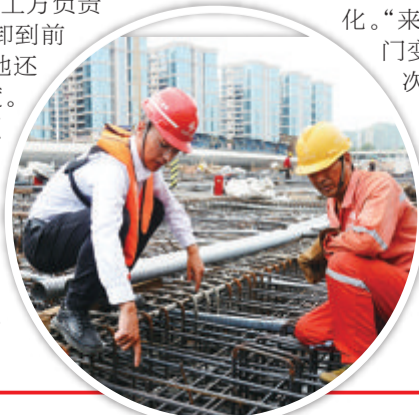
■慕龙(左)巡查施工现场。
