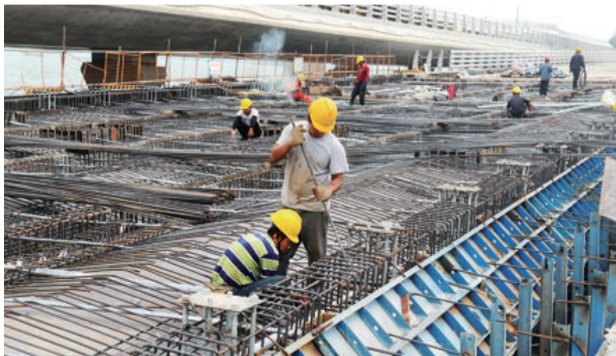
■翔安大桥海上互通区施工现场一片忙碌。
