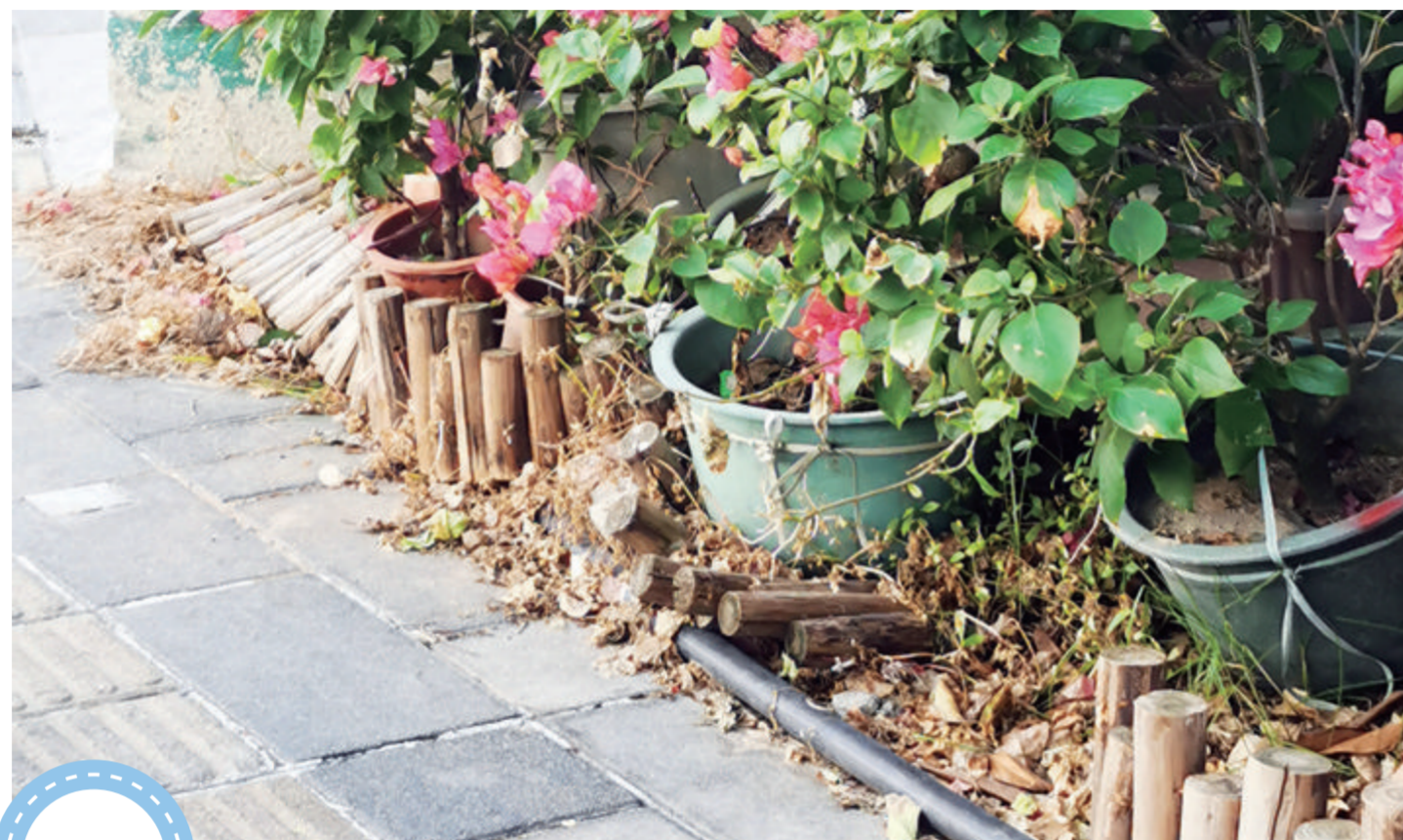
■鹭江道厦禾路交会处一景观小品的木护栏东倒西歪，有碍观瞻。
