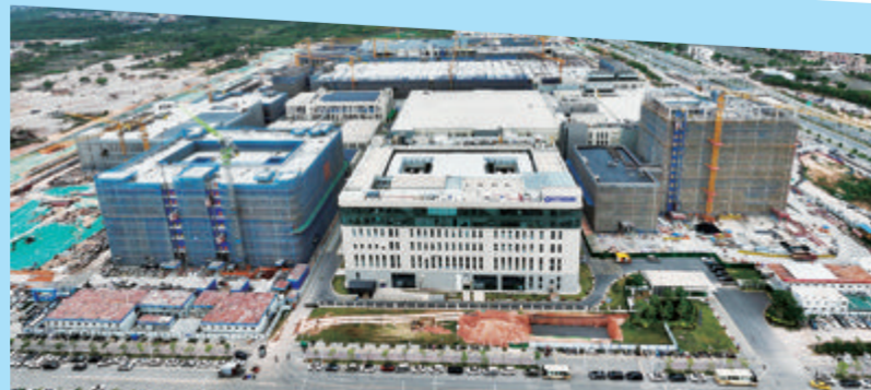
海辰锂电二期项目快速推进中。
