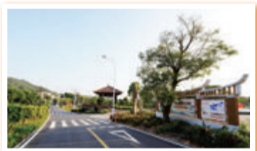
■溪林村近期完成村庄主干道“白改黑”工程。
