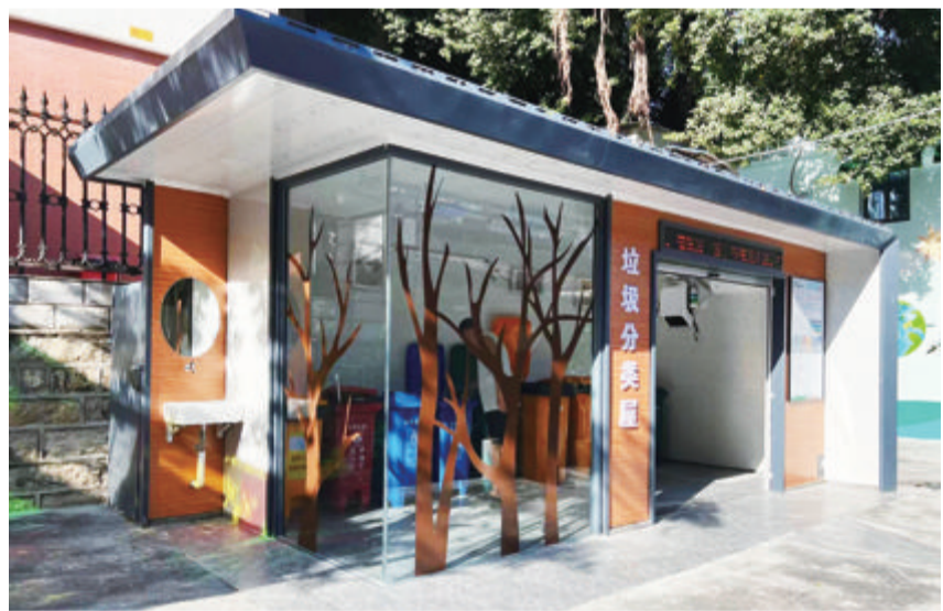
仁安社区这座上月刚投用的垃圾屋,是我市第一座钢化玻璃垃圾屋。
