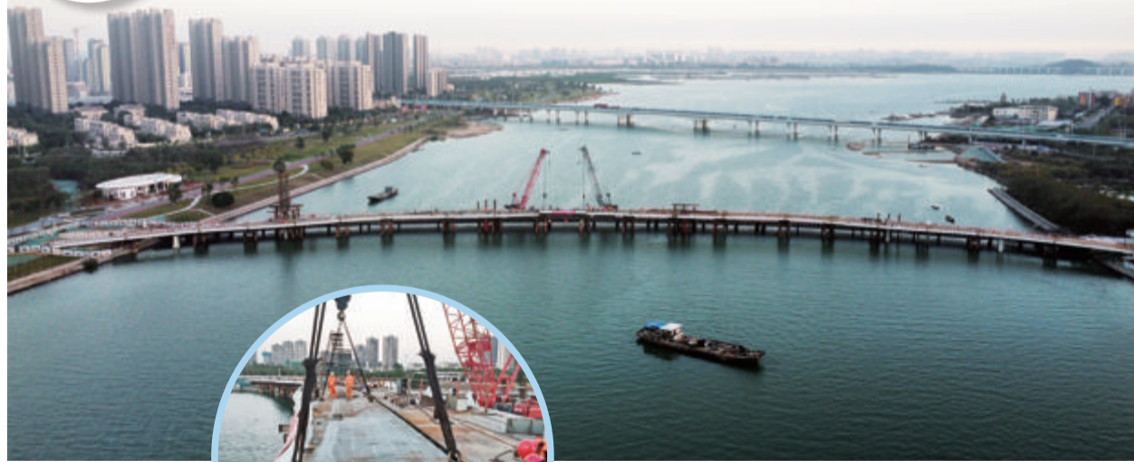
施工人员对钢箱梁进行定位、焊接。
