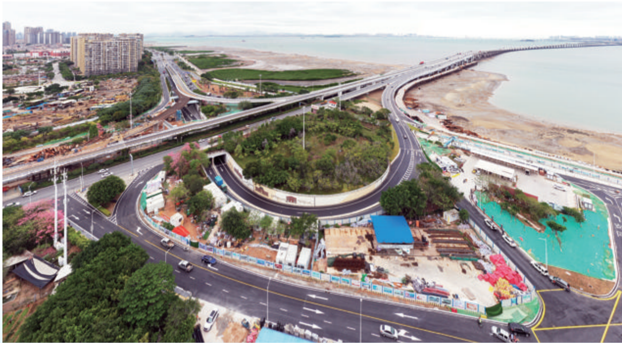
集美大桥桥头立交提升改造工程项目上午正式通车。
