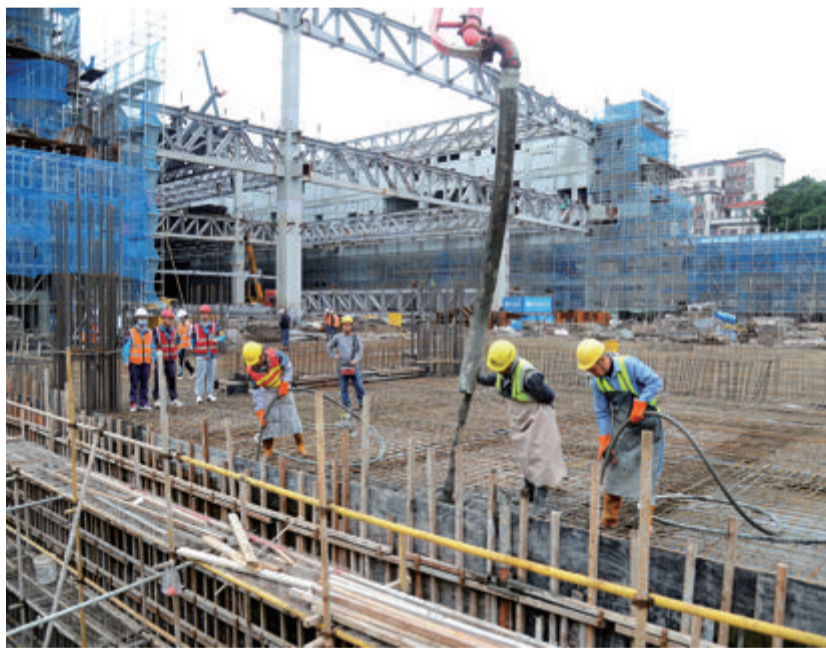
厦门国际会展中心五期项目施工现场。
