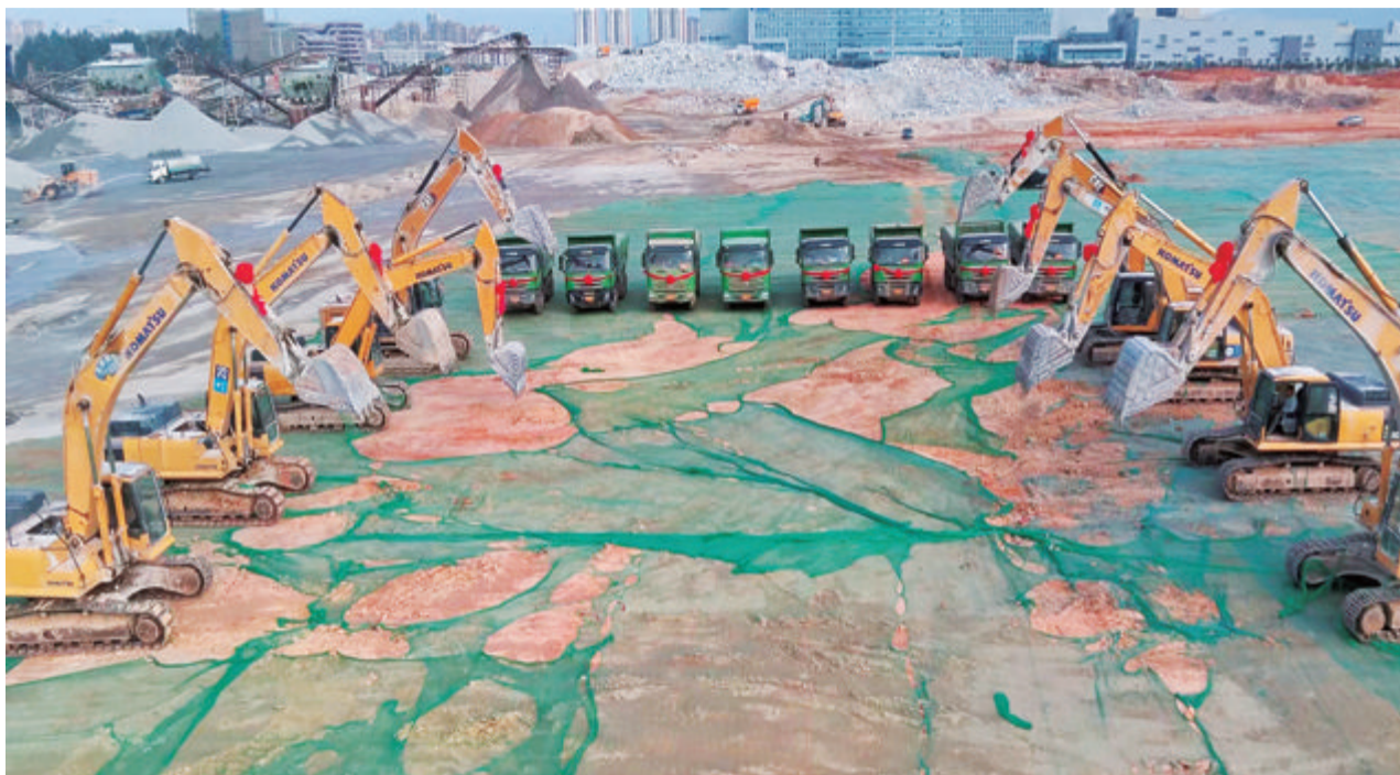
■科华数能高端装备创新产业园项目现场。
