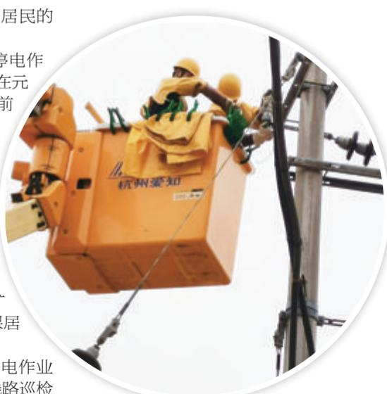
作业人员在绝缘斗臂车上进行高空带电作业。
