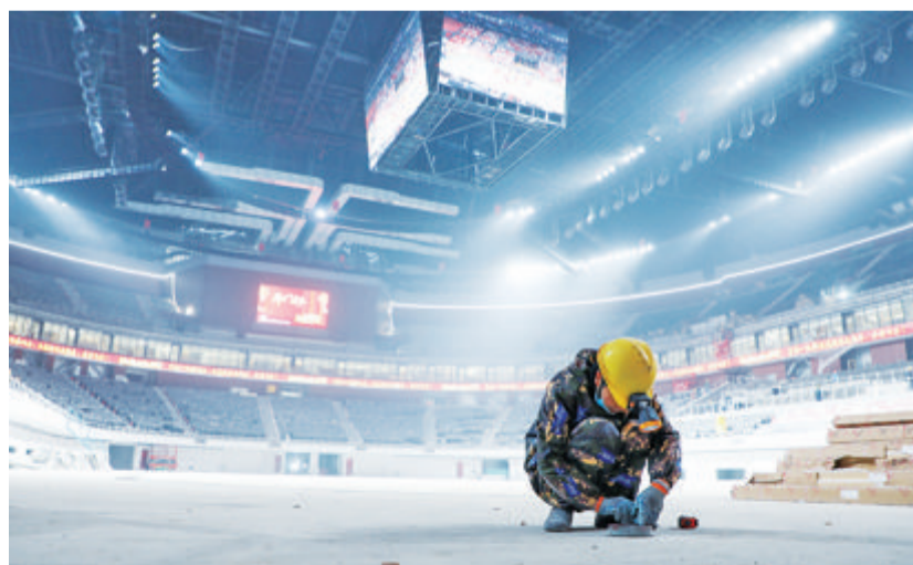
■工人在凤凰体育馆内紧张施工。
