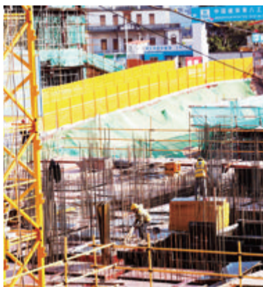
何厝旧村改造项目配套工程施工现场。
