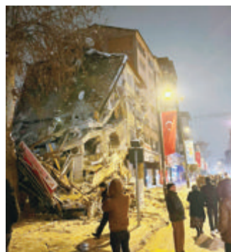
■土耳其马拉蒂亚一处倒塌的建筑。
