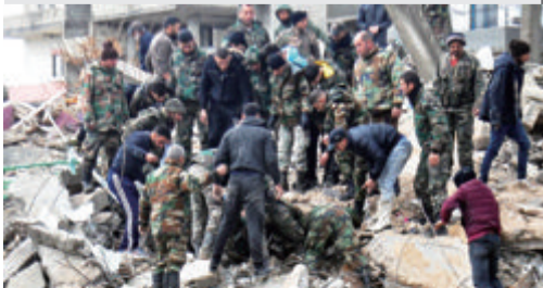
■2月6日，人们在叙利亚拉塔基亚省杰卜莱一处倒塌的建筑现场进行救援。
