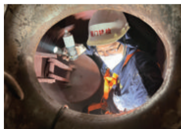
市特种设备检验检测院检验压力容器。
