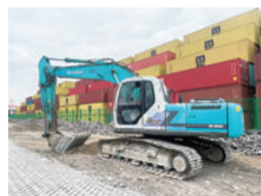
施工现场。海沧融媒体中心供图
