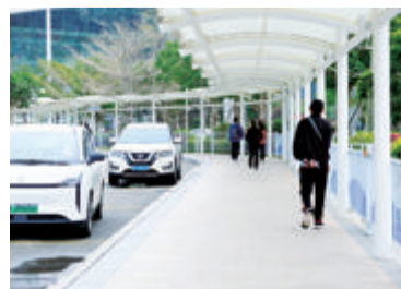
风雨连廊提升市民换乘舒适性。林依文 摄
