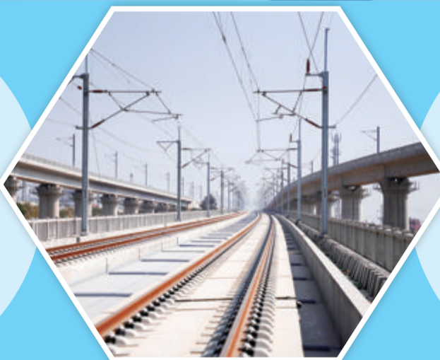
■福厦高铁正线(中间)及进岛联络线(两侧)。陈嘉新 摄
