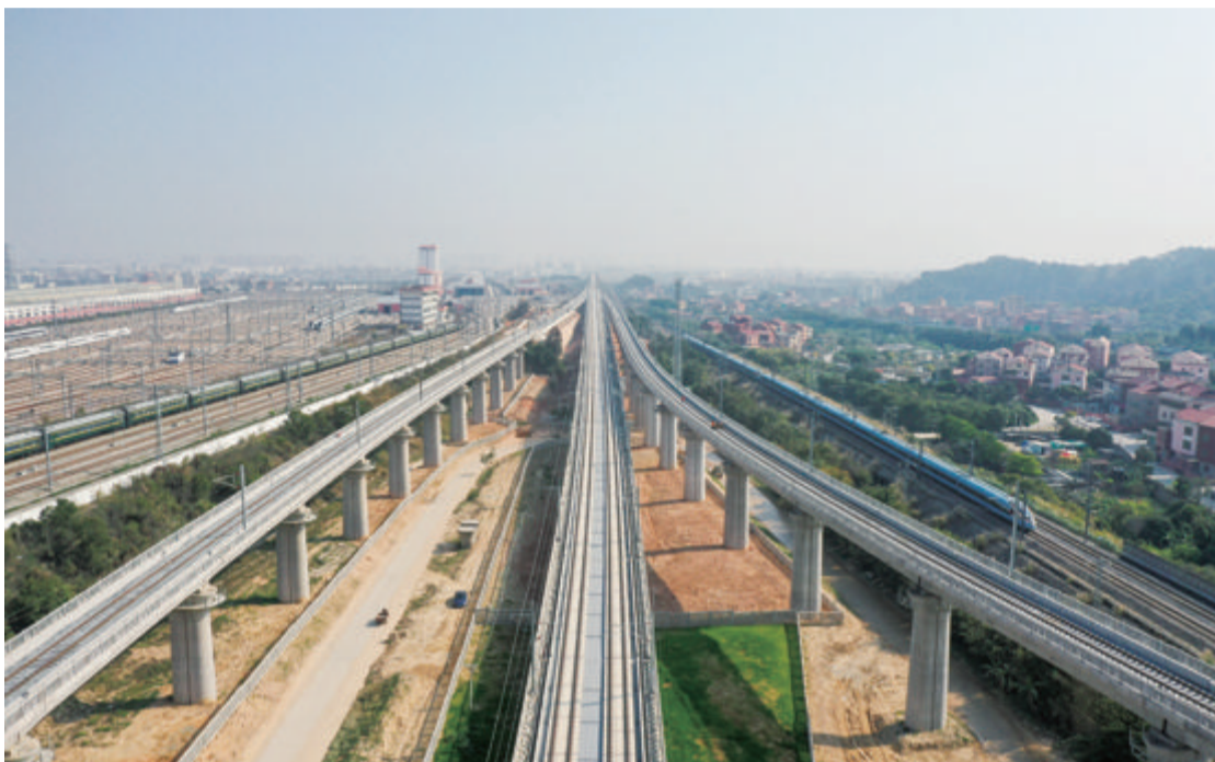
完工后的福厦高铁正线(中)及进岛联络线(两侧)。
