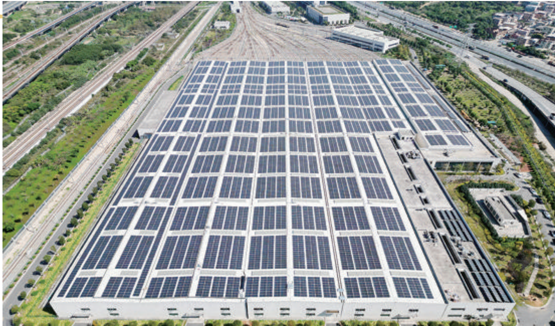
■轨道交通2号线车辆段车库屋顶铺设光伏组件。
