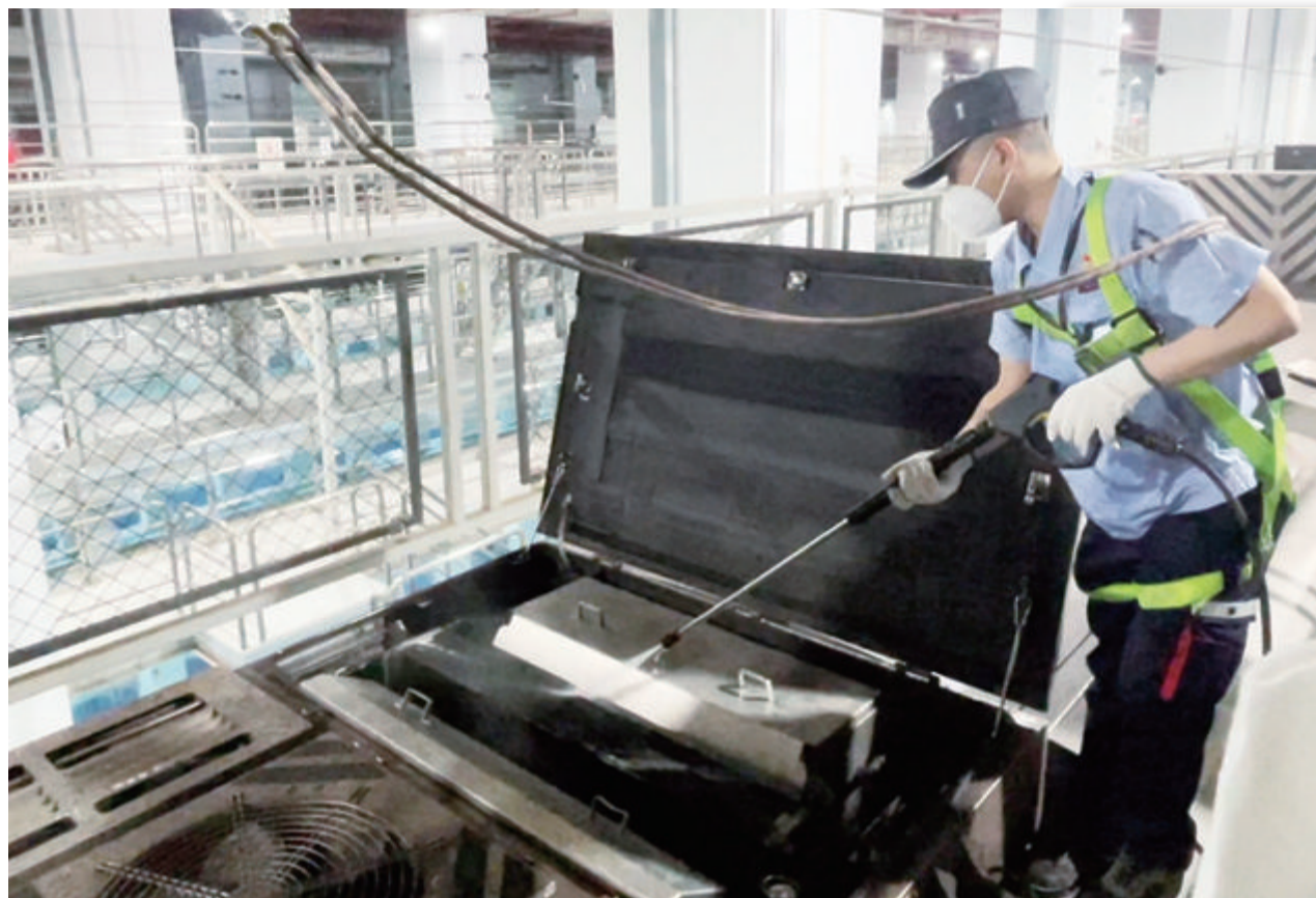
■地铁工作人员用高压水枪清洗空调设备。
