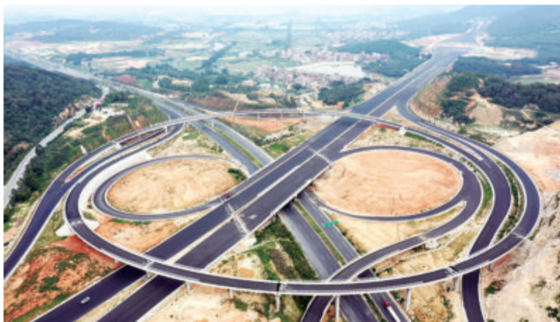
翔安机场高速公路近日完成主线道路沥青路面铺装。
