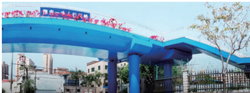
■ 翔安一中人行天桥工程顺利竣工。
