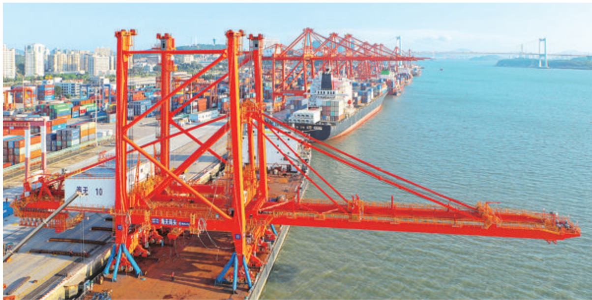
■海天码头引进第一台“原厂”智能桥吊。
